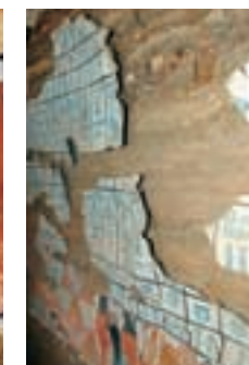
埋葬室東面 波打つプラスター
